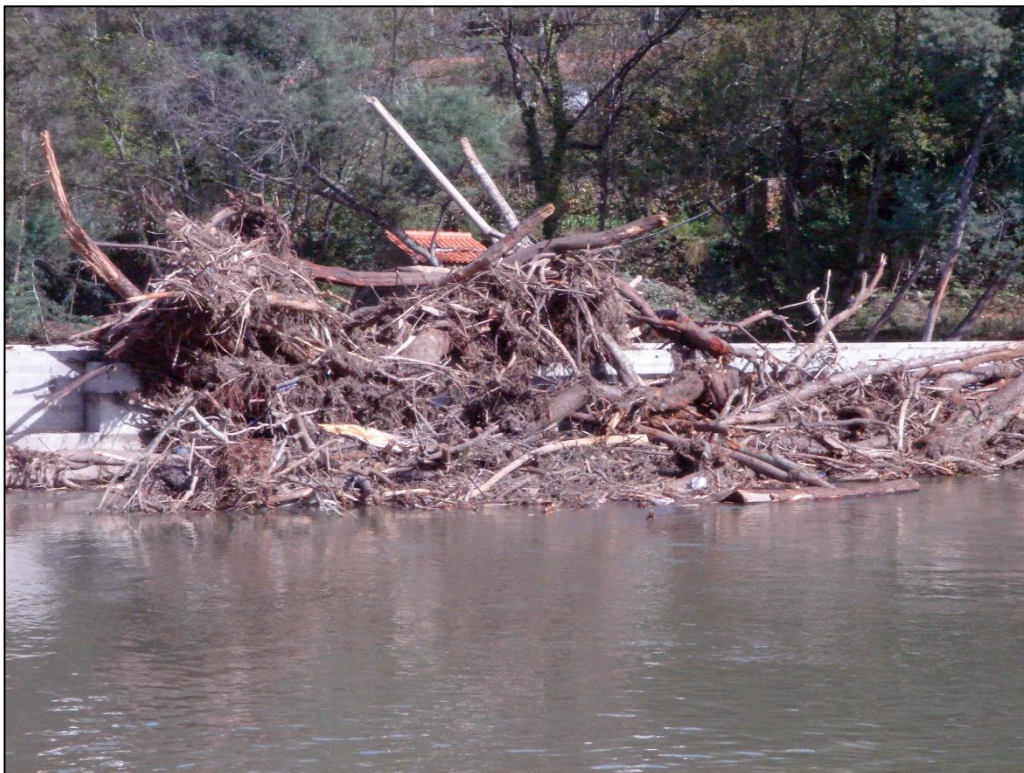
Figura 32. Vistas da praia fluvial de Avô. Pormenor das comportas da praia fluvial de Avô, totalmente obstruídas por material abandonado pela cheia do dia 14 de julho de 2006. Fonte: Luciano Lourenço
