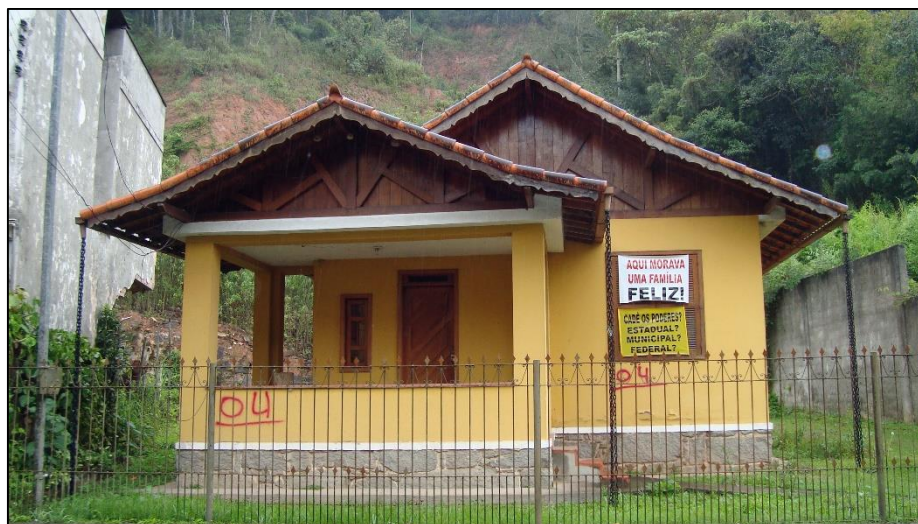
Figura 8a. Moradia em Nova Friburgo, atingida por desastres hídricos, outubro de 2013.
