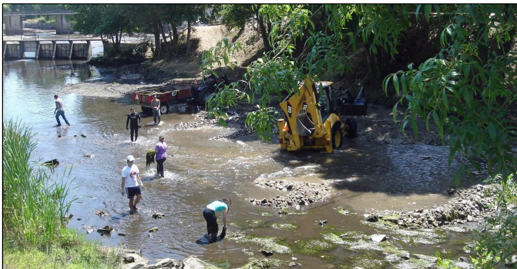
Figura 55. Aspetos de pormenor das operações de limpeza da piscina fluvial de Penalva de Alva. Remoção de detritos a jusante.
