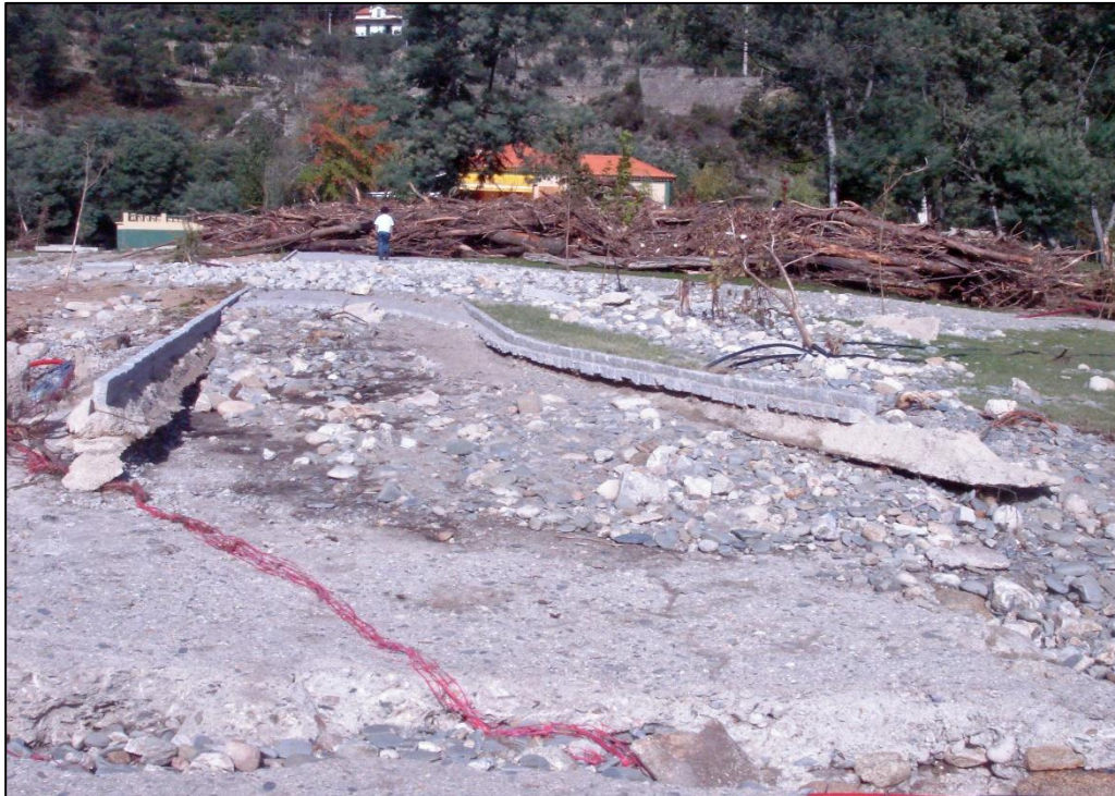
Figura 31. Vistas da praia fluvial de Avô: Detalhe da destruição do acesso à ilha do Picoto e do amontoado de árvores nela abandonadas pela cheia do dia 14 de julho de 2006. Fonte: Luciano Lourenço.
