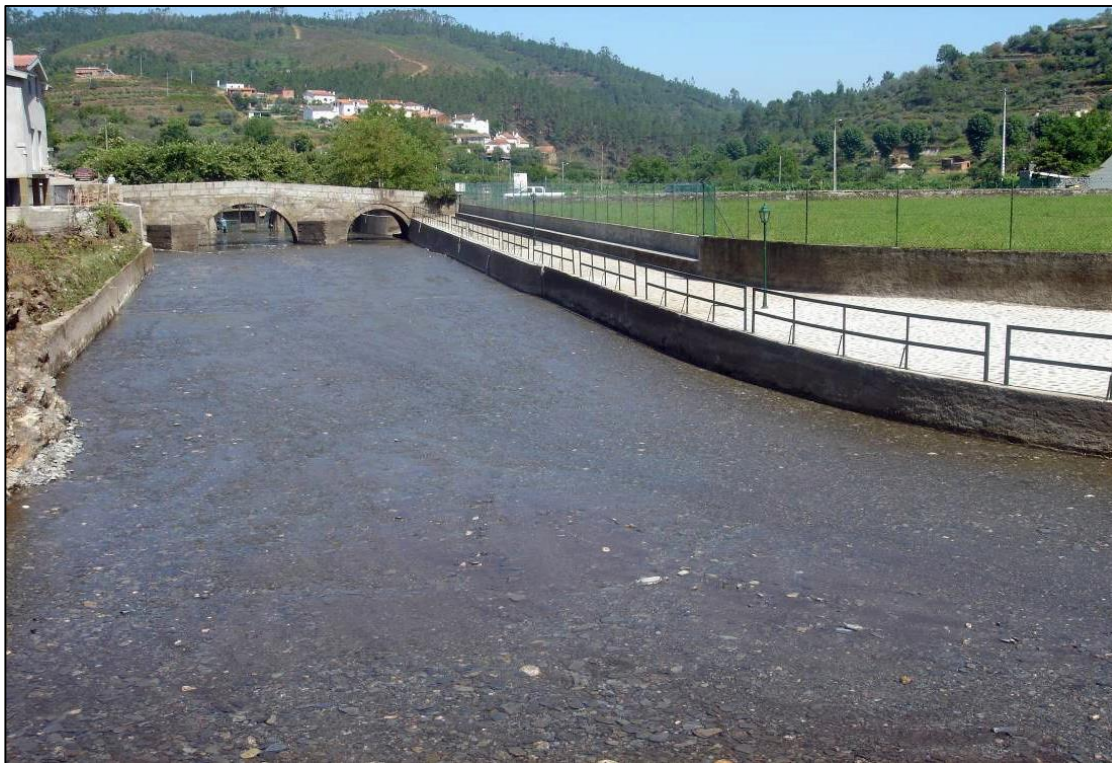
Figura 13. Aspeto da piscina fluvial de Pomares após as obras de reabilitação, ainda sem as comportas de retenção da água.
