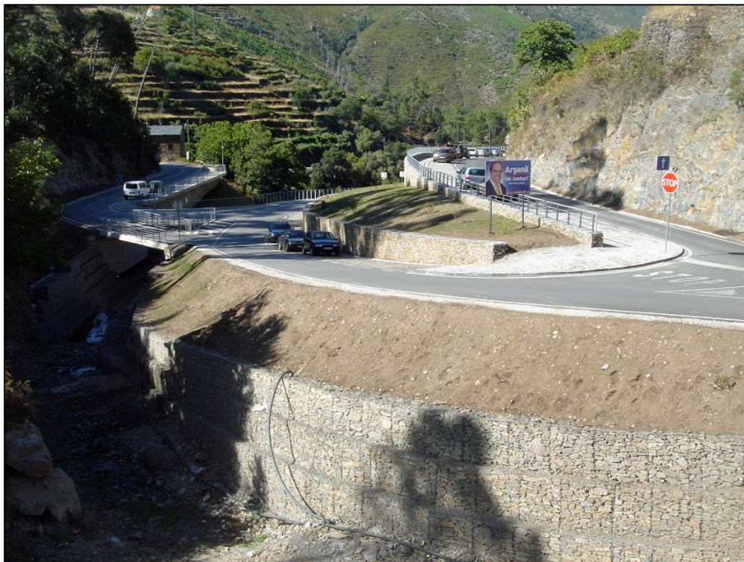
Figura 40. Parque estacionamento do Piódão, depois das obras de recuperação.
