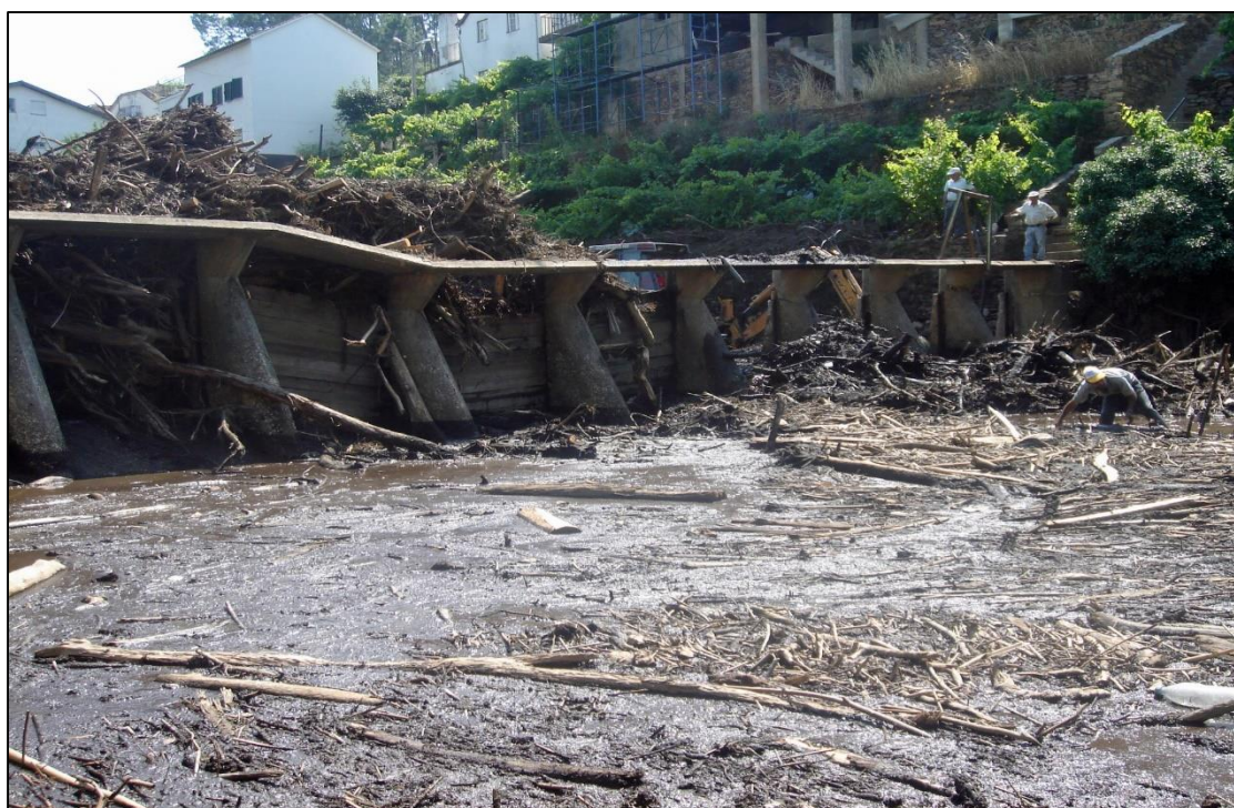
Figura 22. Aspeto da operação de remoção, para jusante, dos materiais acumulados no dique da piscina fluvial da Vide, uma semana após o episódio de 16 de junho de 2006.
