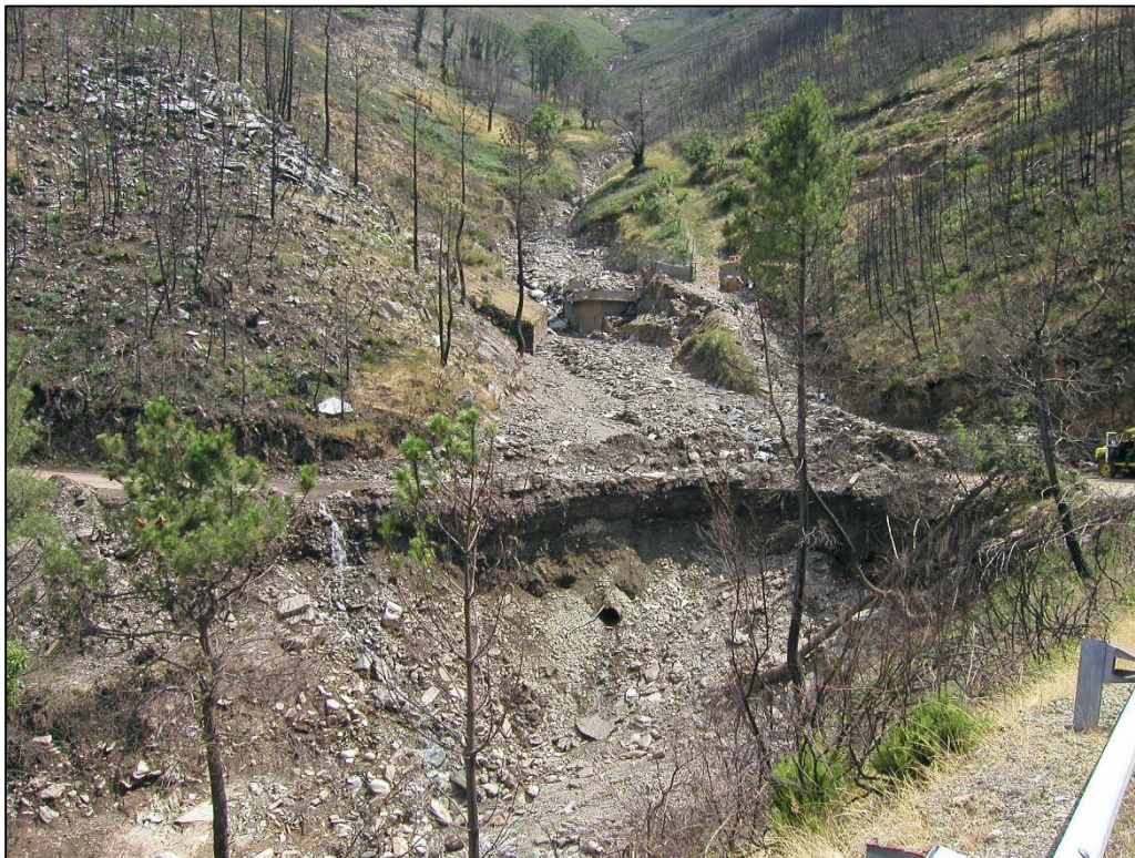
Figura 35. Evolução do corte da estrada de Chãs de Égua. Vista geral do material transportado, que fossilizou a estrada, e da erosão a jusante, provocada pela cheia do dia 14 de julho de 2006.
