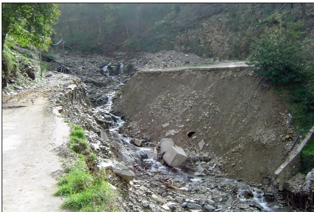
Figura 39. Destruição do parque estacionamento do Piódão, evolução posterior, na sequência das precipitações de setembro e outubro de 2006, com devolução da linha de água ao seu antigo talvegue, ao lado do qual se vê uma manilha que atesta a antiga conduta subterrânea.
