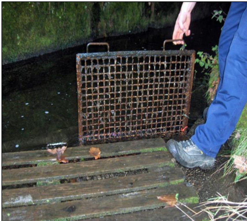
Figura 45. Pormenor da grelha para retenção de materiais colocada na entrada de água para abastecimento a partir da barragem da Senhora do Desterro. Fonte: Fotografia amavelmente cedida pelo Gabinete Técnico Florestal de Seia.
