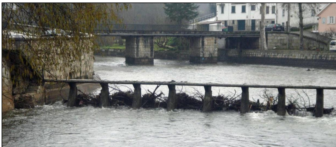
Figura 59. Pormenores da deposição de cinzas na praia fluvial de São Sebastião da Feira após a cheia de janeiro de 2013.
